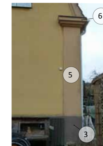
Fig. 27. Plastered socle (3). Pilasters (5). Simple capital (6).
