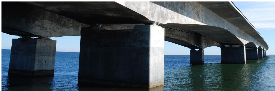
Figur 5.2 Punktupplag på bro.
