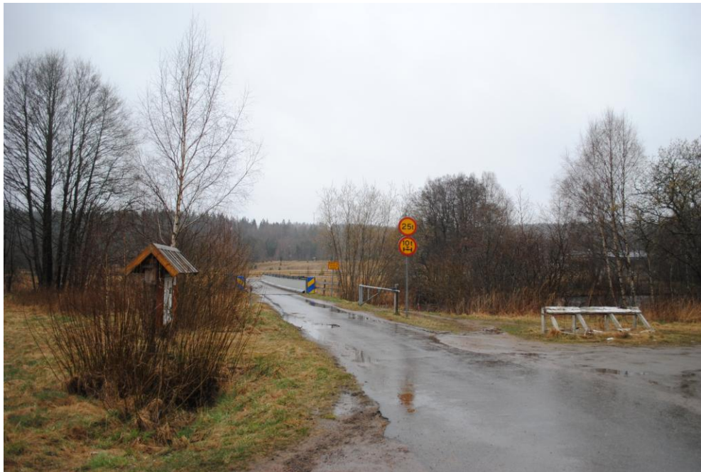
Bild (C2).1. Befintlig vägbom vid sektion 3/330.
