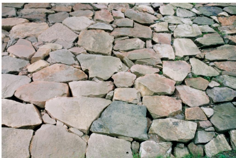
Bild (DC41).1. Eftersträvad stenläggning i brokoner innan komplettering med kross i fogar.
