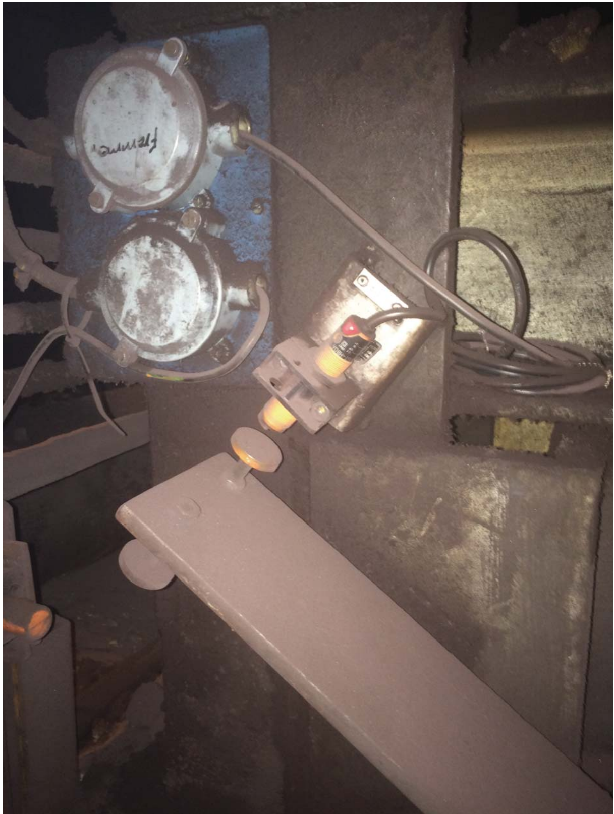
Figur 23. Induktiv givare för stegbalksrörelse, Uddeholms AB. Författarens egen bild.
