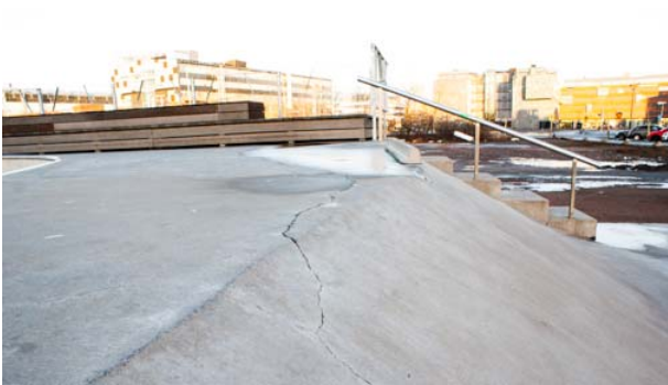
Figur 35 Sprickbildning i Stapelbäddsparken (Alvefelt 2015)
