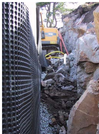
Arbete med återfyllning mot grunden
