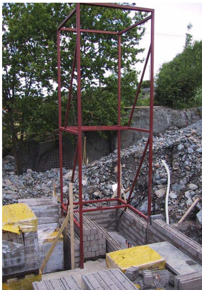
Trapphusets stomkonstruktion av stål
