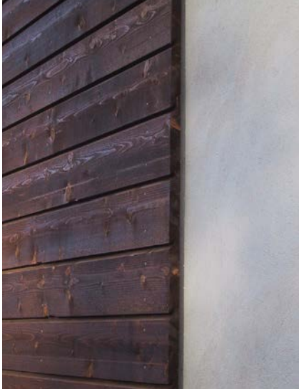
Detalj, södra sidans fasadpanel omsluter muren
