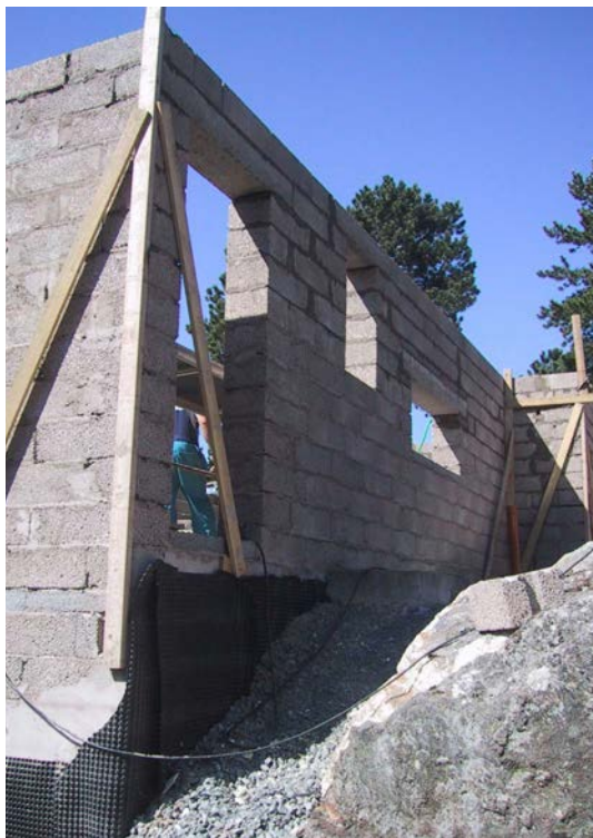
Uppförande av murstomme, juni 2008.
