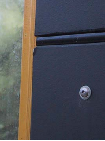
Principdetalj skarvning av mineritskivor på trapphus
