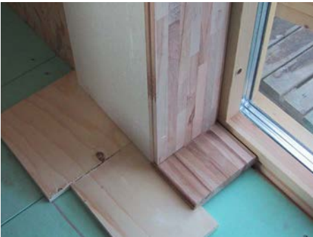
Tester inför montage av smygbrädor
