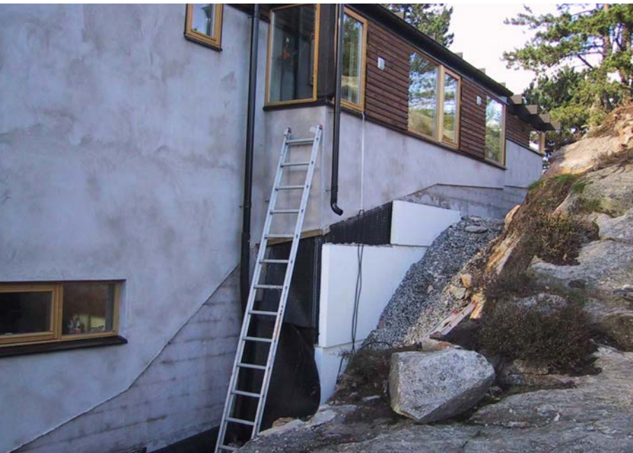
Inför återfyllning på östsida
