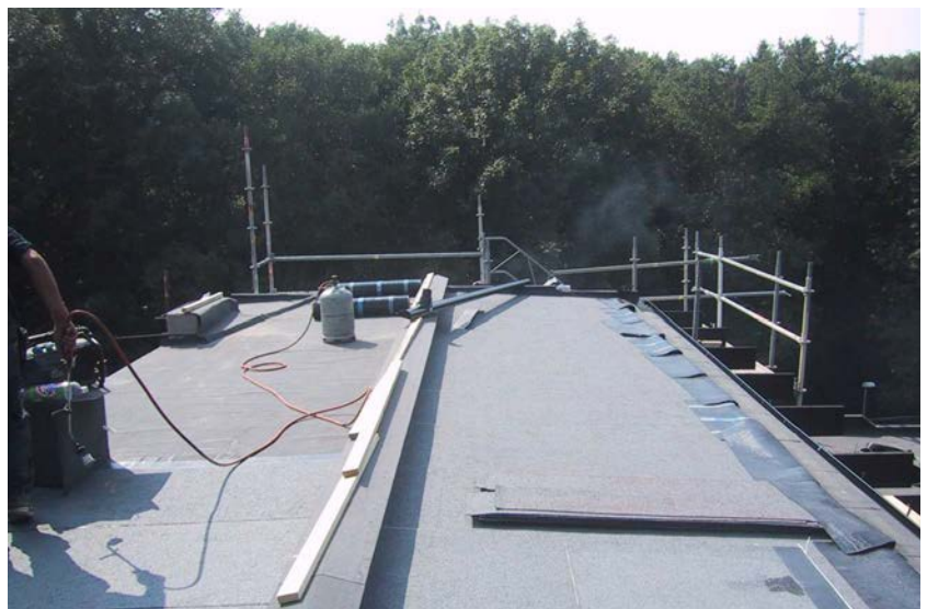
Läggning av papptaket
