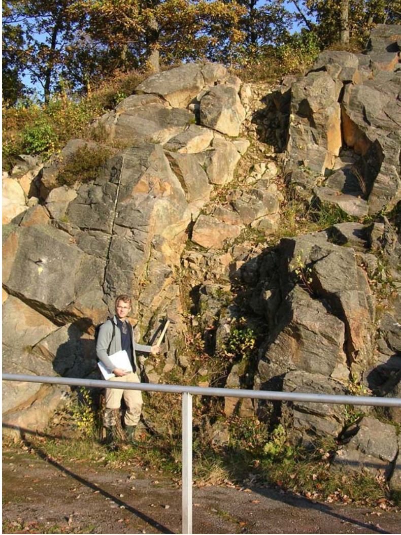
Figur 3.37, En tydlig krosszon genom bergskärningen.
