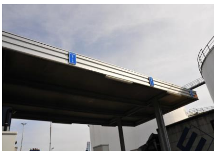
Figur 63 Förslag på placering av RFID-läsare i hamnportens stoppzon
