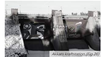
Akkats kraftstation (Fig 26)
