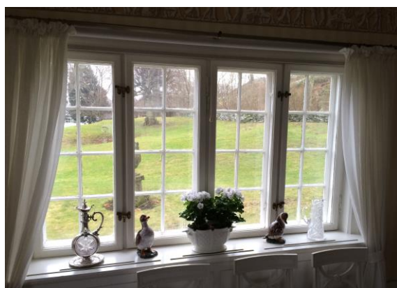
Figur 2.4 Fönster med åtta smårutor och två lufter. Sett inifrån ett av rummen på nedervåningen (Lindstrand 2014).
