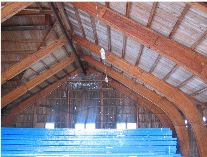
Bild 1 (Törebodas gamla fabrik, limträbågar i taket)
