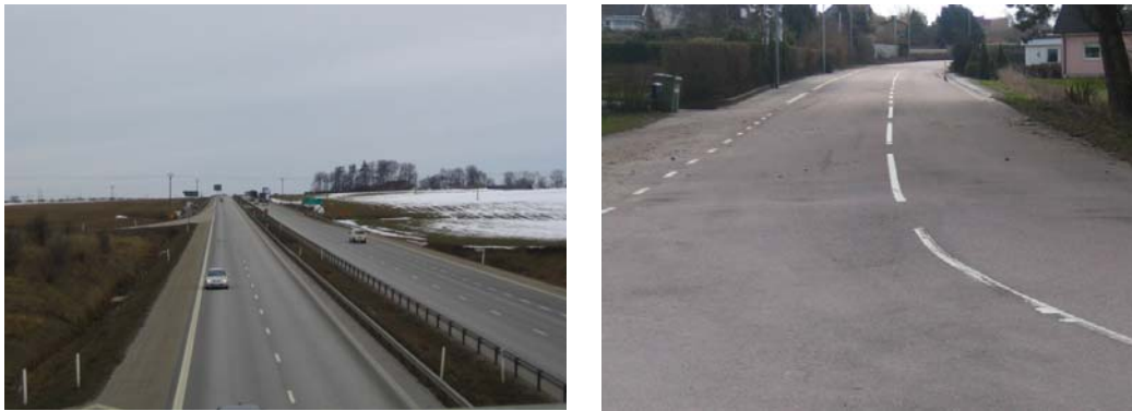
Figur 1: Till vänster syns en statlig väg som förvaltas av Vägverket, på den högra bilden syns en kommunal gata.
