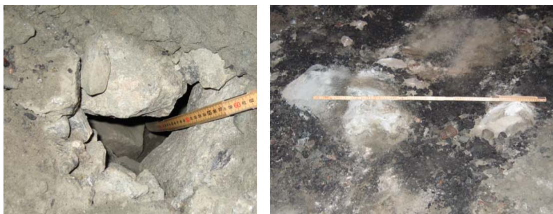
Figur 5.2 Vänstra bilden visar underminering som upptäcktes vid urgrävning. Högra bilden visar storsten/block i dagen efter brytning av asfalt.[5]
