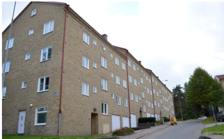
Byggnaderna följer terrängen. Även här tegel i en naturnära gulbrun ton samt sadeltak.
