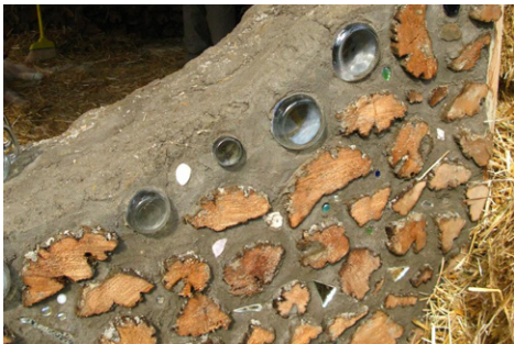
Vägg med kubb, glasflaskor och bruk under konstruktion (quite.fyre, 2012)
