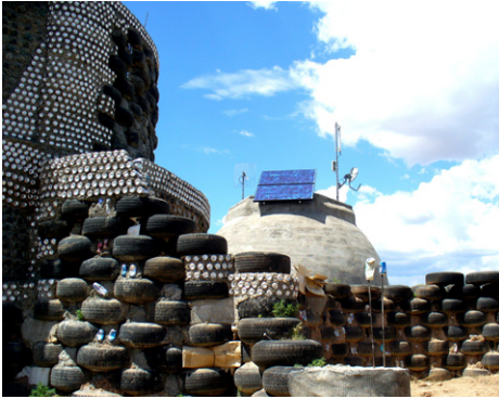
Earthship av bland annat däck och aluminiumburkar i New Mexico (Prochnik, 2009). Viktigt att tänka på när man överväger den här typen av material är dock att de kan medföra skadliga utsläpp.
