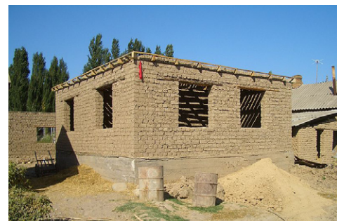
Hus av adobe under konstruktion i Kirgizistan (Vmenkov, 2007).
