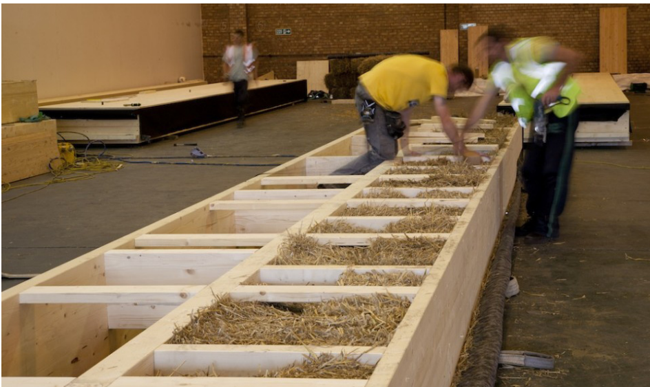
De långa träpanelerna fylls med halm (Olsen, 2011).
