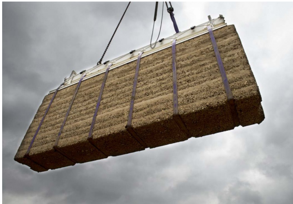
En modul av enbart stampad jord lyfts med kran för att sättas på plats i Ricola Herb Centre, Schweiz (Bühler-Rasom, 2012).
