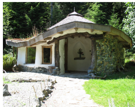
Cobhusets organiska former kompletteras av de noga utvalda stockarna som ramar in entrén (Thomassen, 2007).
