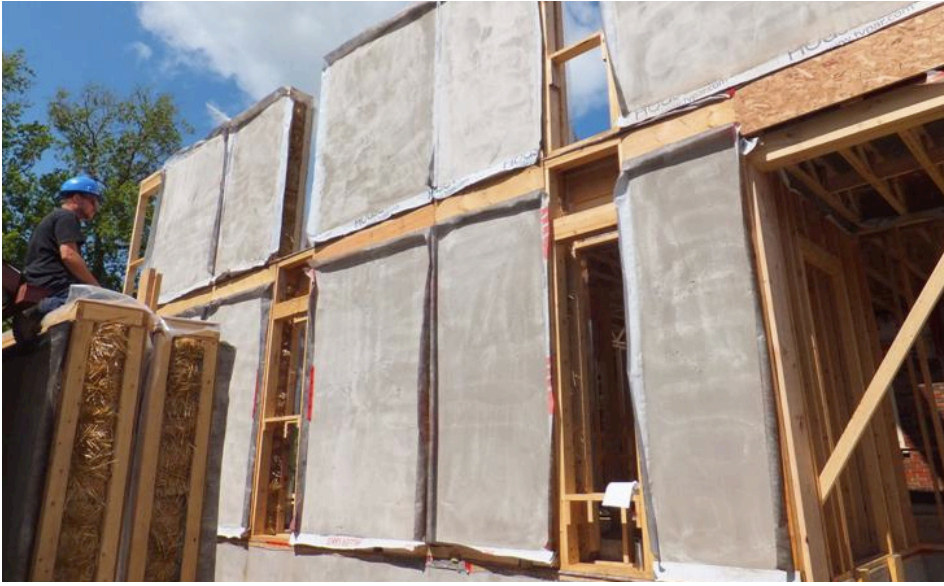
Montering av NatureBuild Bio-SIP i Kanada (NatureBuilt, 2012).
