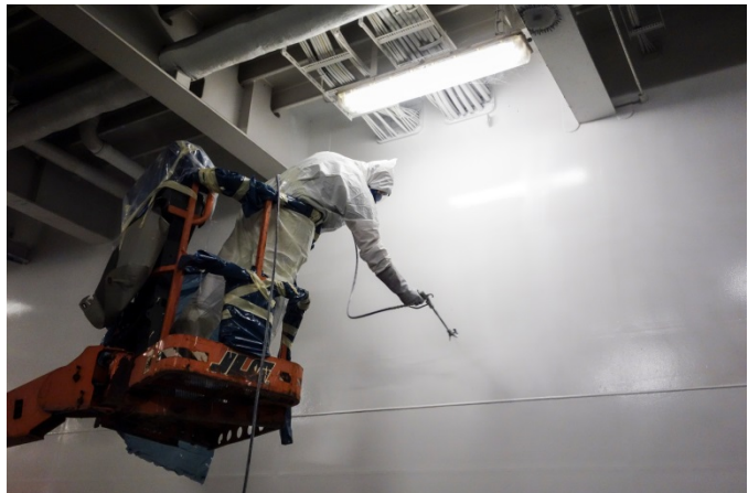
Figur 1. Spraymålning från sky-lift (Henrysson 2014).
