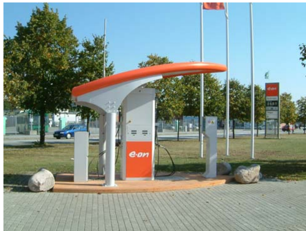
Figur 3: E.ON:s vätgastankstation på Nobelvägen förser två stadsbussar i Malmö med en blandning av naturgas och vätgas. Foto: Staffan Ivarsson
