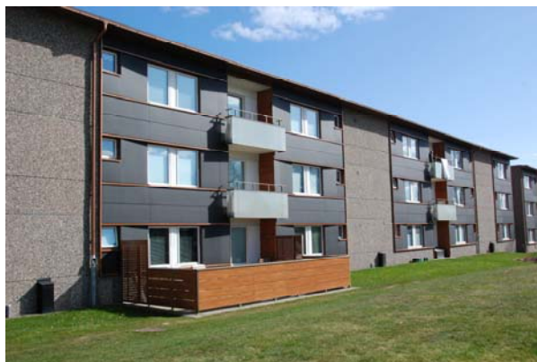
Figur 16 - Ny fasad med fönster och balkonger.
