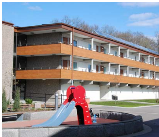
Figur 24 - Loftgångshus och ny lekplats.
