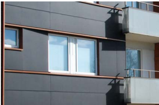
Figur 13 - Ny fasad runt fönster och balkong.
