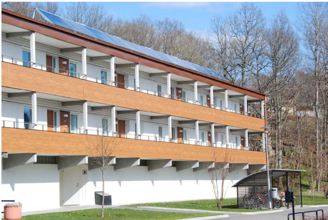
Figur 17 - Loftgångshus med solpaneler på tak.
