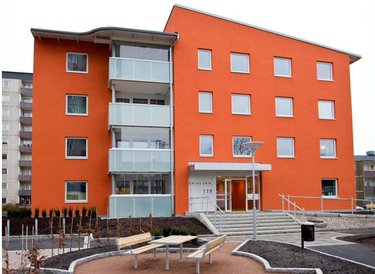
Figur 3 - Katjas gata 119 i slutskedet av renovering.
