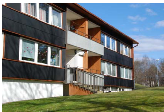
Figur 18 - Fasad mot innergård, observera utskjutningen av taket.
