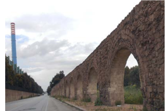
Ancient aqueduct Del Triglio
