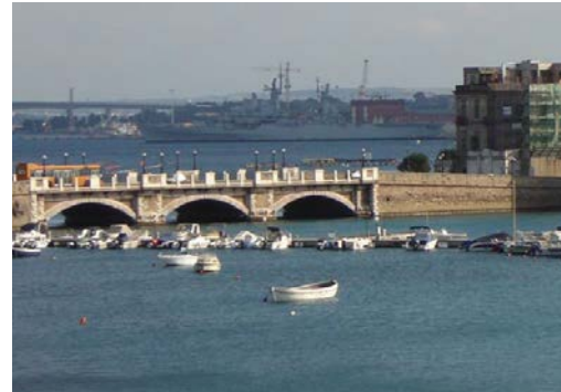
Bridge Ponte di Porta Napoli
