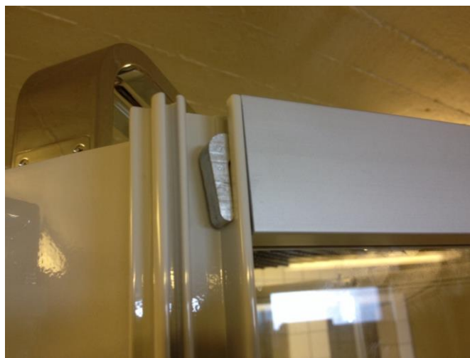
Figur 2.7 Montering av bakre vägg
