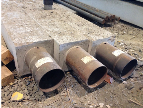
Figur 12 Skarv på betongpåle för att ansluta till en träpåle (Börjesson 2014)
