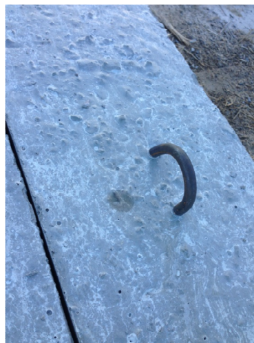
Figur 9 Ögla som används för att lyfta pålen (Fridhagen 2014)
