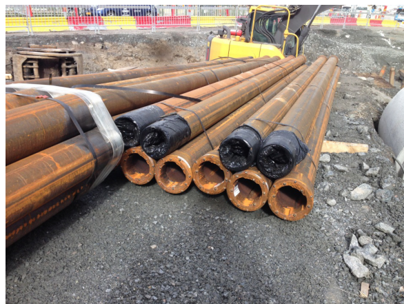
Figur 5 Stålpålar på projektet Skeppsbron (Fridhagen 2014)
