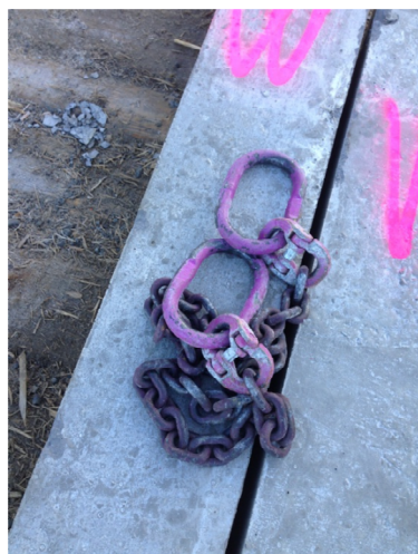
Figur 8 Kedja som används för att lyfta pålen (Fridhagen 2014)
