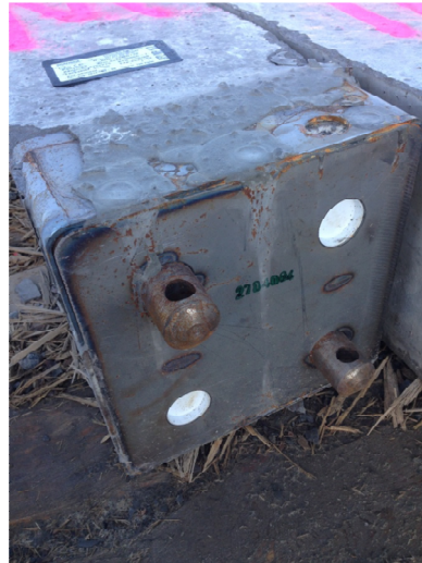
Figur 11 Skarv på betongpåle (Fridhagen 2014)
