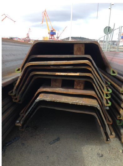
Figur 4 Spontplank på projektet Skeppsbron (Fridhagen 2014)
