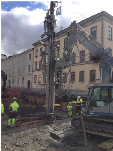
Figur 13 Borrning av stålpålar (Fridhagen 2014)
