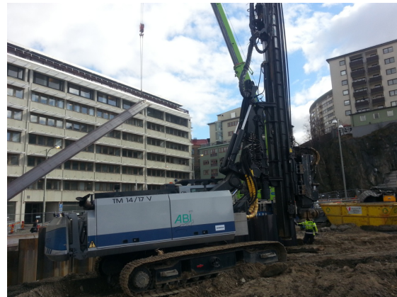
Figur 16 Lyftning av spontplanka (Börjesson 2014)
