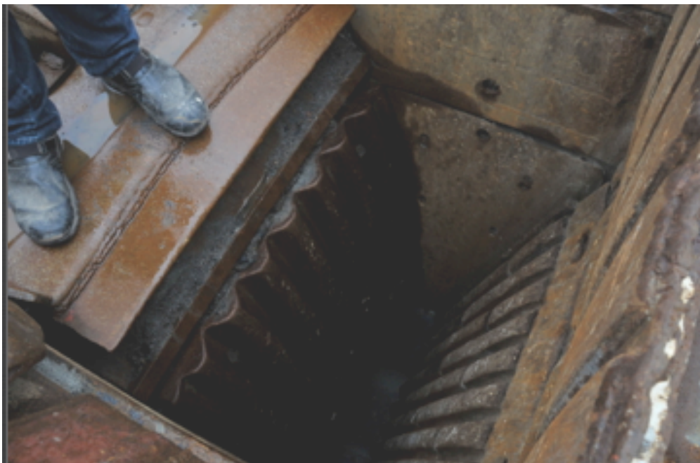
Figur 1.4: Inlopp till käftkross, monteringskilen syns på krossplattans överkant.
