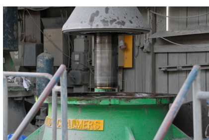
Figur 1.10: Axelpaketet lyfts ur.
