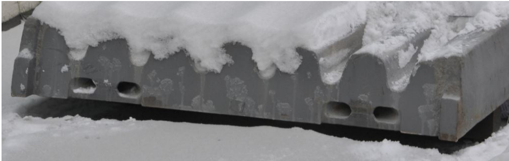
Figur 1.2: Lyftpunkter krossplatta, Sandvik.
