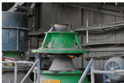
Figur 1.8: Topphalvan lyfts av.
