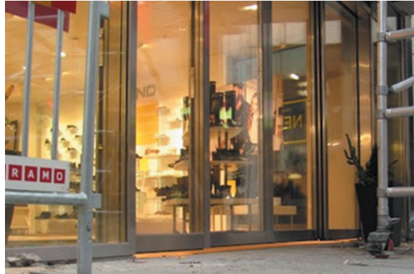
Bild 3 Stor glipa mellan dörrsystem och golv
