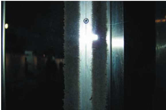
Bild 2 Tillplattade borstar i ett dörrbladsmöte
