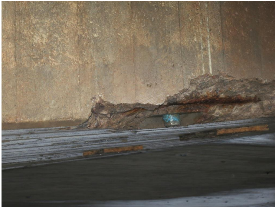
Figur 2 Korrosionsskada.
