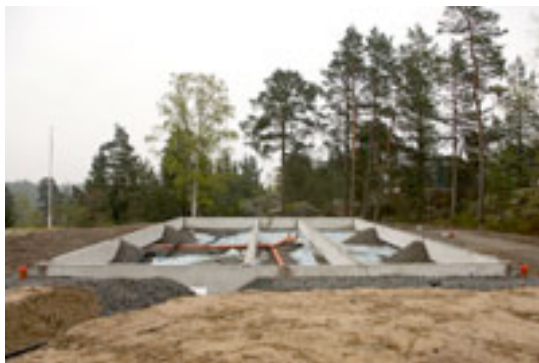
Figur 10: Oventilerad kryppgrund (Karell, 2010).
