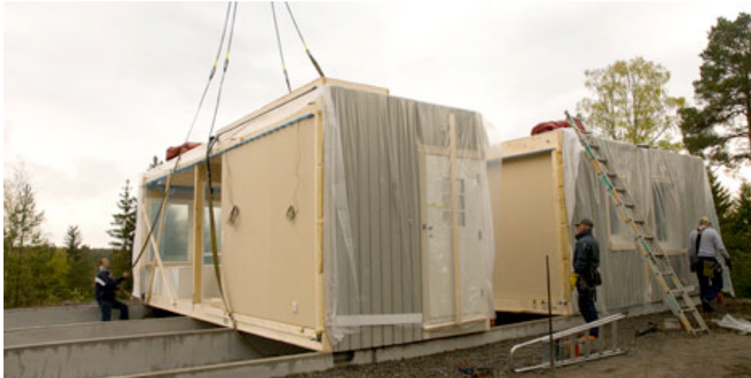
Figur 9: Kranmontering av en husvolym till ett volymhus (Karell, 2010).
