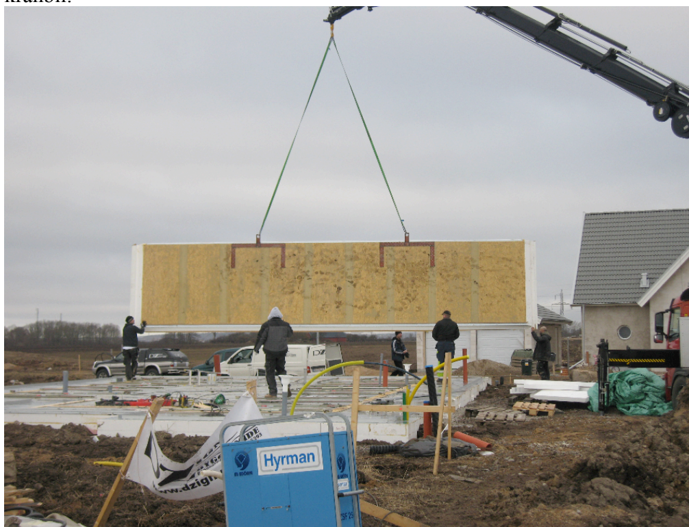
Figur 6: Kranmontering av Novazips SIPs-element (Novasip.se, 2014).
