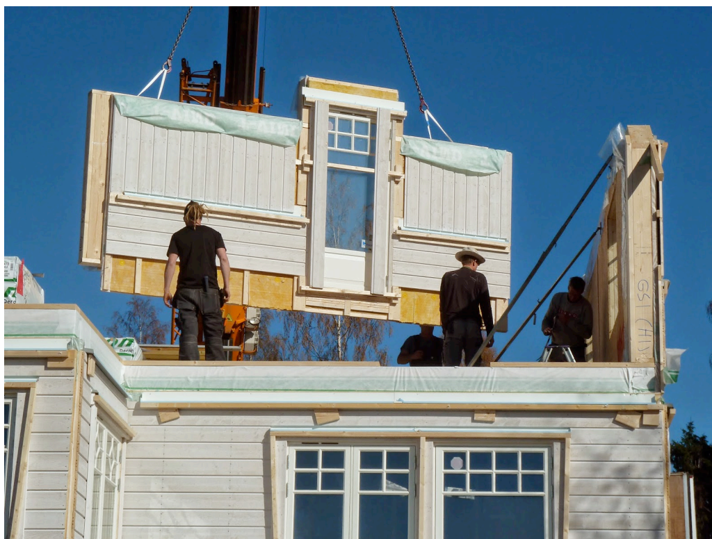
Figur 8: Kranmontering av modolvägg (Hemtillmyrstacken.blogspot.se/, 2014).
