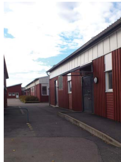
Eriksboskolans lokaler består av röda envåningsbyggnader i trä.
