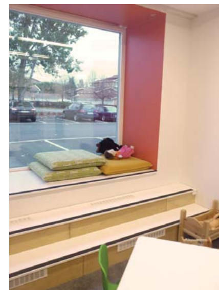
En inbyggd trappa i en djup fönstersmyg får flera funktioner
