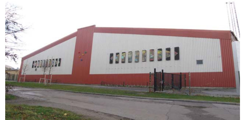
Rosengård ishall med konstverk som pryder plåtfasaden. (Malmö stad 2013)
