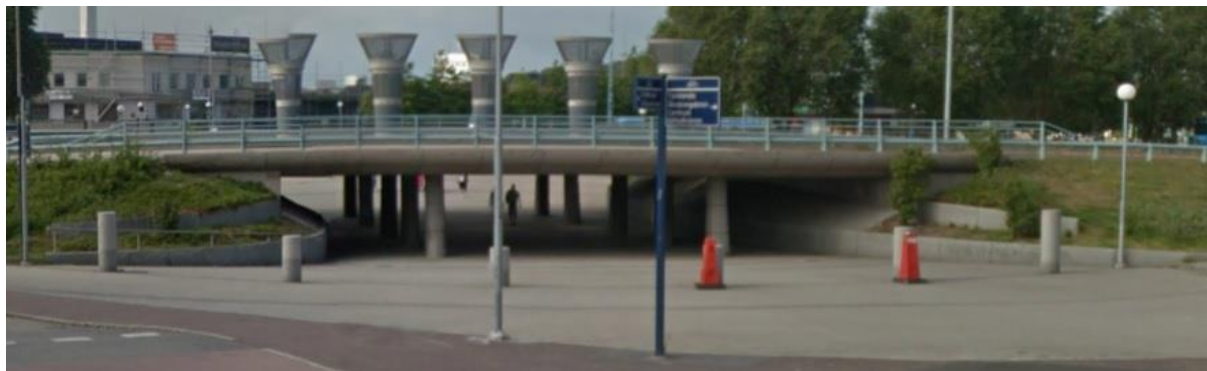
Bild 8 Gång- och cykeltunnel vid Hjalmar Brantingsplatsen efter ombyggnation (Google Earth, 2014-04-10).
