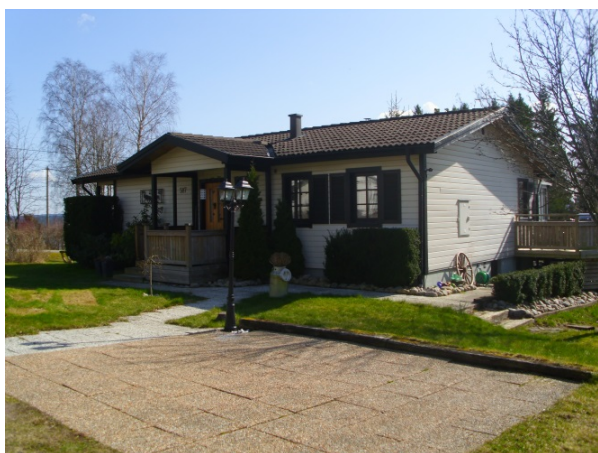
Bild 11: Stuga i Höggeröd med en uteluftsventilerad kryppgrund.
