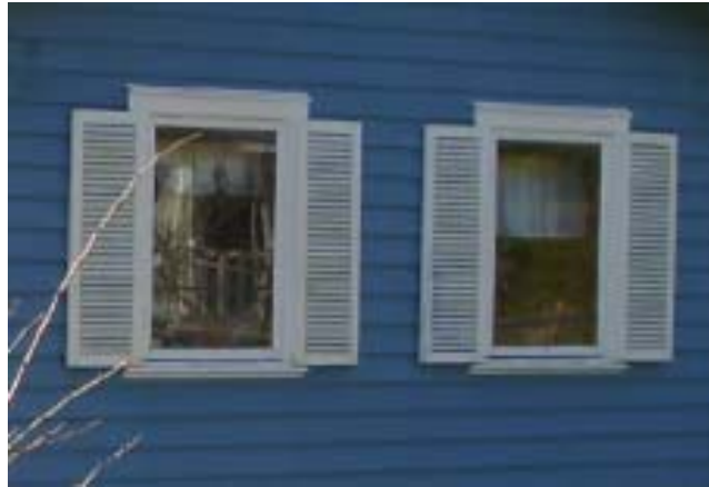
Bild 14: Fönsterluckor i fasad på ett hus i Höggeröd.
