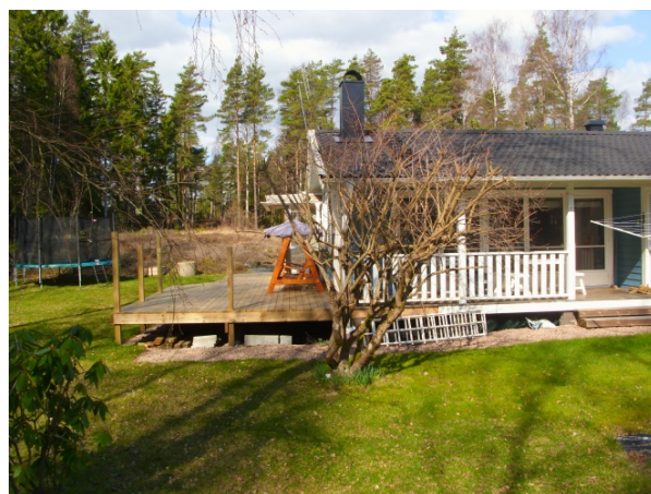
Bild 12: Stuga i Höggeröd med en öppen plintgrund under altanen.
