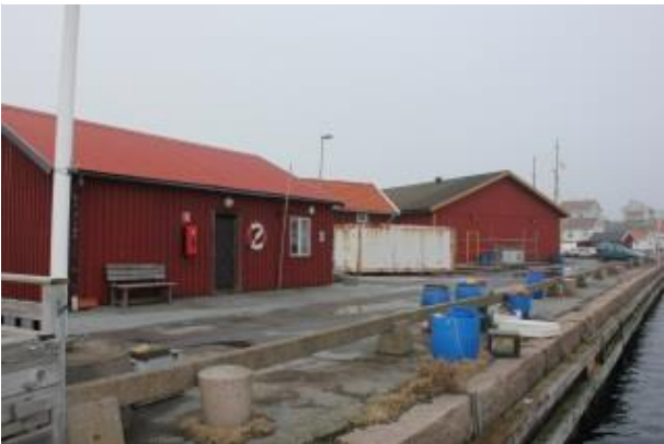
Figur 10. Industritomten från sydost (Foto: författarna).
