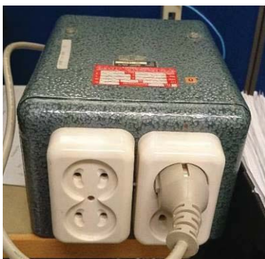
Figur 20: "Isolationstransformator "skyddstrafo" kopplat till oscilloskop"
