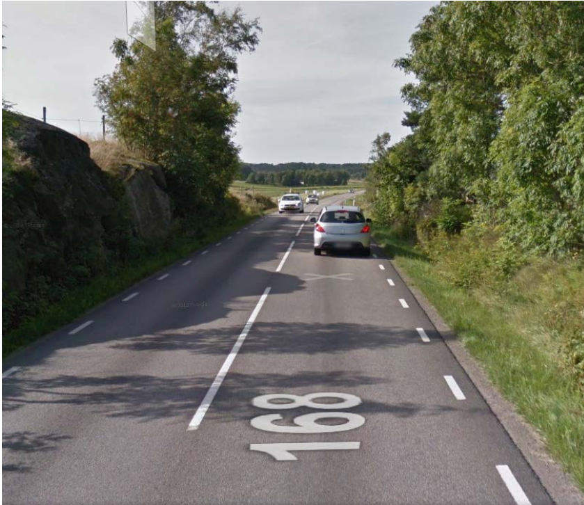
Figur 6A. Visar på en vägsektion med berg vid ena sidan och vegetation på andra vilket skapar en känsla av en trång sektion framför allt vid möte.
