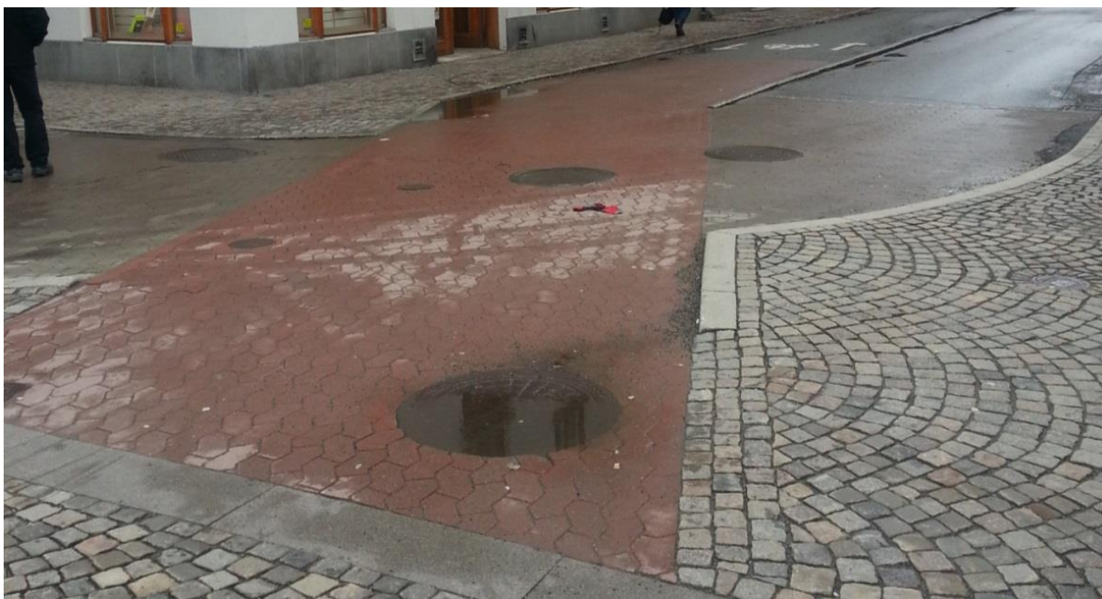
Figur 2.5 - Cykelöverfart vid Järntorget med beläggning av röd sten.
