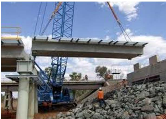
Figur 19 - Kran lyfter broelement på plats (FormworkBlog, 2008).
