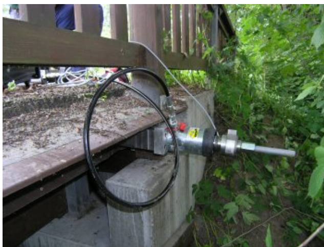
Figur 62 - Kontroll av spännkraften i tvärspänd träplatta (Svenskt trä, 2014).
