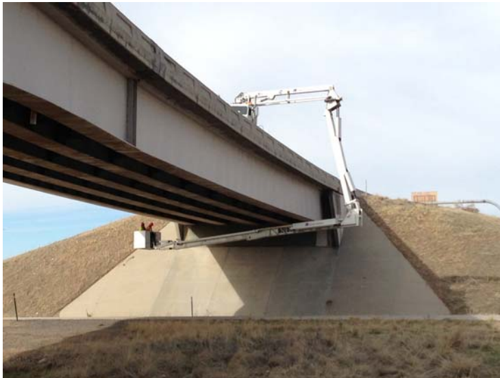
Figur 16 - Inspektion av en balkbro med hjälp av en kranbil (Transportation Blog, 2012).
