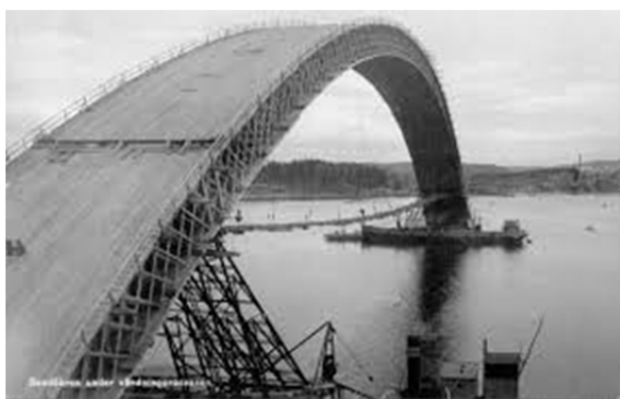
Figur 17 - Tillfällig träform vid brobygge (Famgus vykort, 2010).
