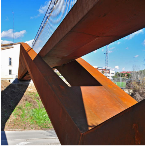
Figur 14. Bro i Cor-ten-stål (dezeen magazine, 2010).
