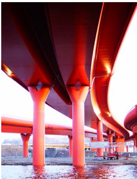
Figur 2. Balkbro med två parallella lådbalkar i stål.
