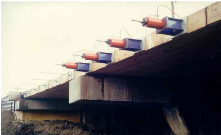
Figur 21. Hydrauliska spännare spänner samman broplattan till en solid träbalk (RTA, 2008).
