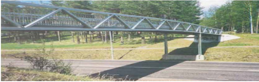
Figur 22 Fackverksbro över väg 70 i Borlänge (Vägverket, 1996).
