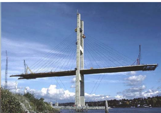
Figur 20. Balanserad utbyggd snedkabelbro (Somerset).
