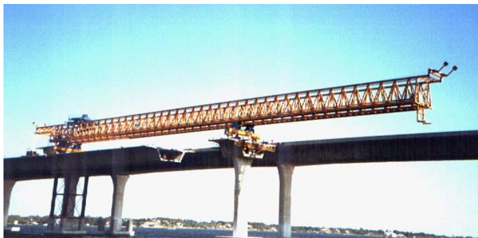
Figur 21. Spann för spann-metoden (Lount, 2003).
