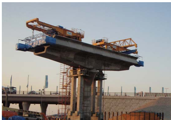
Figur 19. Balanserad konsolutbyggd balkbro (DNEC, 2011).
