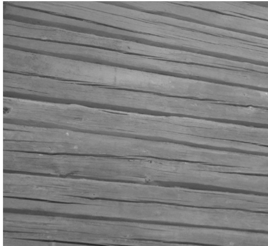
Sprickbildning i bilat timmer (boningsbus från Norra Finnskoga socken)
