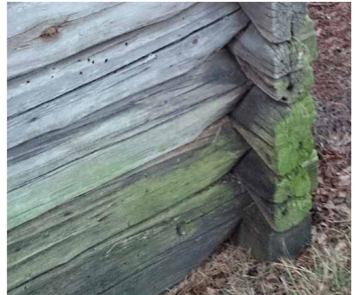
Vägg på dålig grundläggning
