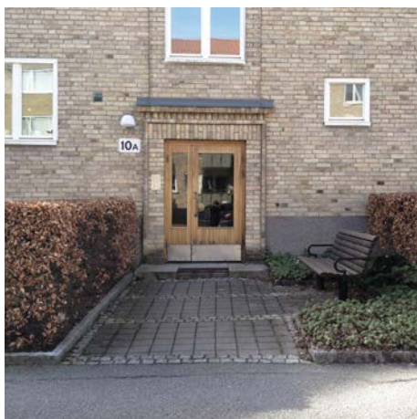
Omsorgfullt utformad entré, Södra Guldheden.
