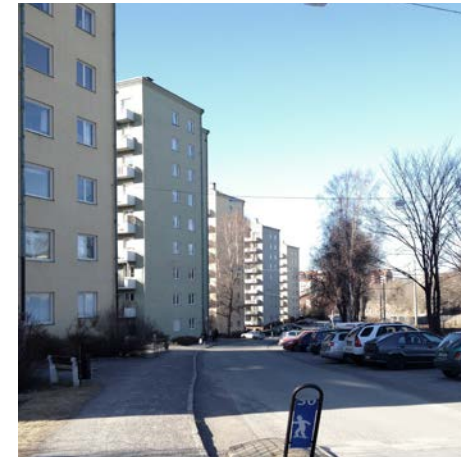
Punkthus anslutna till lokalgata, Södra Guldheden.
