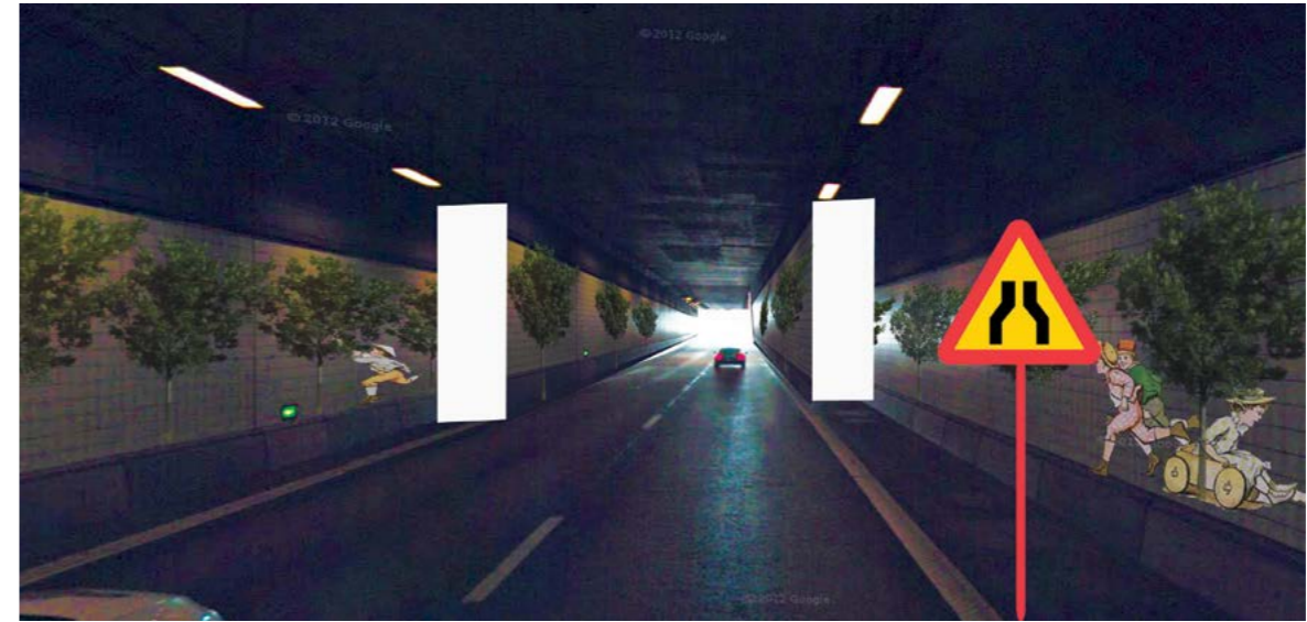
Hastighetsdämpande 2 Avsmalning av väg gör att föraren skapar sig motiv att sänka hastigheten med hänsyn till den egna säkerheten.
