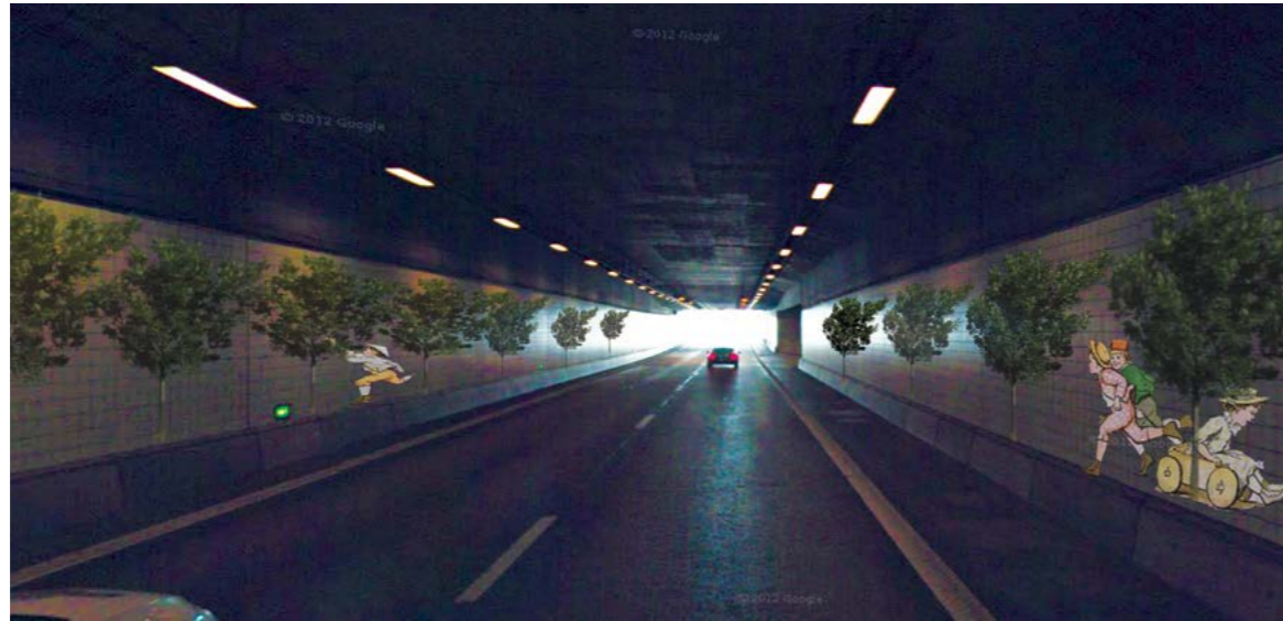
Hastighetsdämpande 1. Målningar av träd och lekande barn skapar uppfattningen om att här kan någonting dyka upp.
