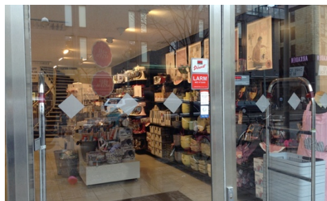
Figur 28: Bred markering på glasyta, för lite kontrast
