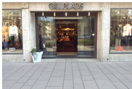
Figur 31: Entré, glasdörr med få kontrastmarkeringar
