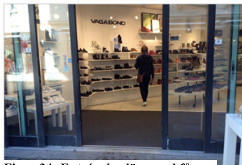
Figur 34: Entré, glasdörr med få kontrastmarkeringar
