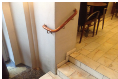
Figur 18: Ledstång i trappa, för kort
