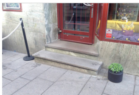
Figur 17: Trappsteg i entré
