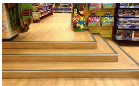
Figur 26: Trappa i butiken, utan ledstänger
