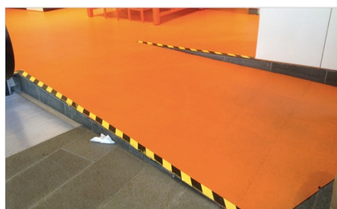
Figur 41: Ramp till butiken samt fastighetens gemensamma hiss och toalett
