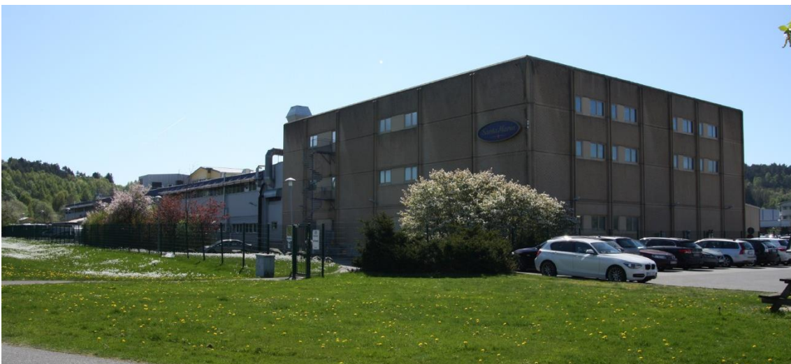
Figur 5.3 Vy över lager- och produktionsbyggnaderna med hus 1 i förgrunden
