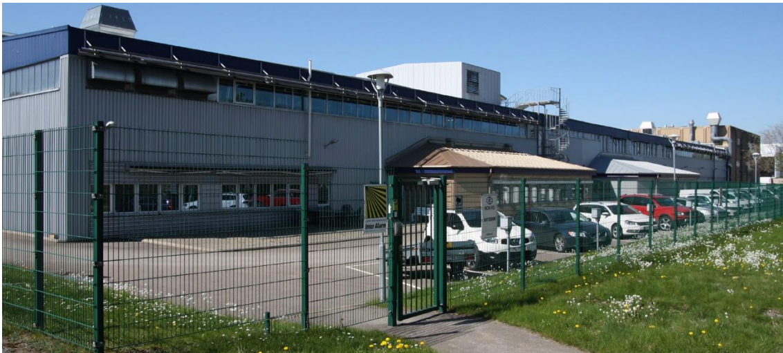
Figur 5.4 Vy över lager- och produktionsbyggnaderna med hus 4 i förgrunden
