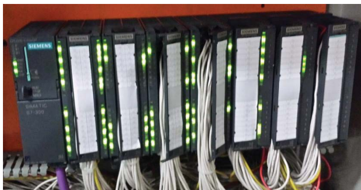
Figur 1: Exempel på ett PLC-system (Bild: Nina Brinktell)
