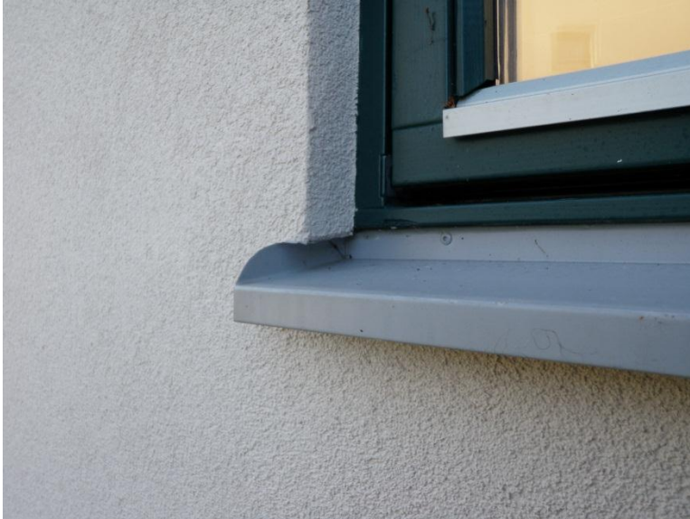
En putsad regelvägg med ett fönster
