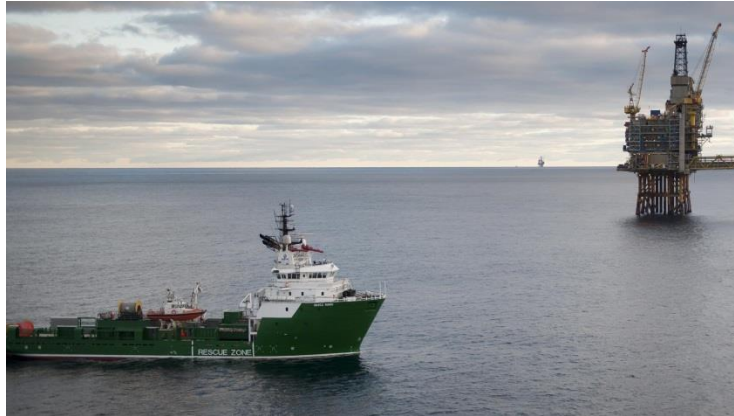
Figur 14. Standbyfartyg i beredskap intill en installation (Statoil, 2010c)
