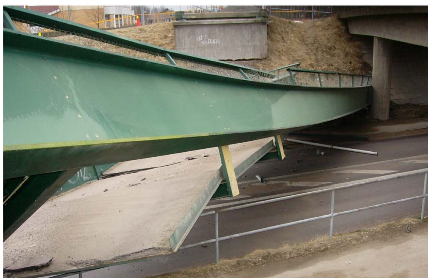
Figur 1.1 Broöverbyggnadens läge efter kollapsen.
