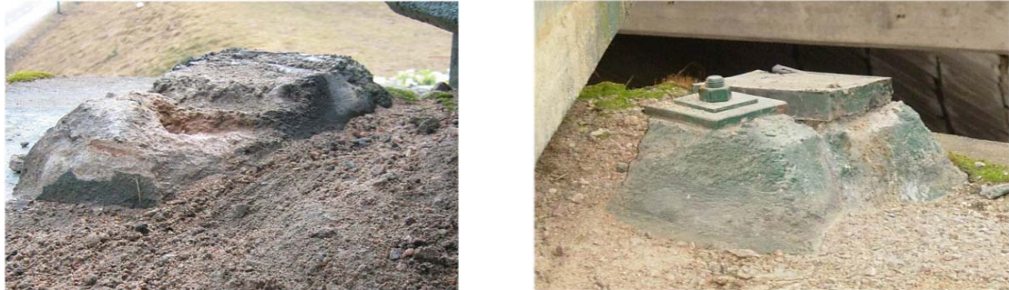
Figur 4.6 Bilden till vänster visar den skadade undergjutningen vid det sydvästra upplaget och bilden till höger visar den intakta undergjutningen vid det nordvästra upplaget.
