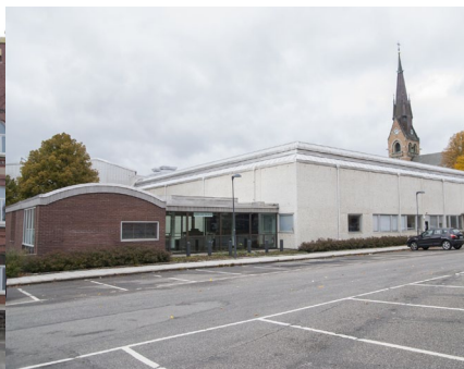
Kulturhuset, fasad mot Bäckängsgymnasiet
