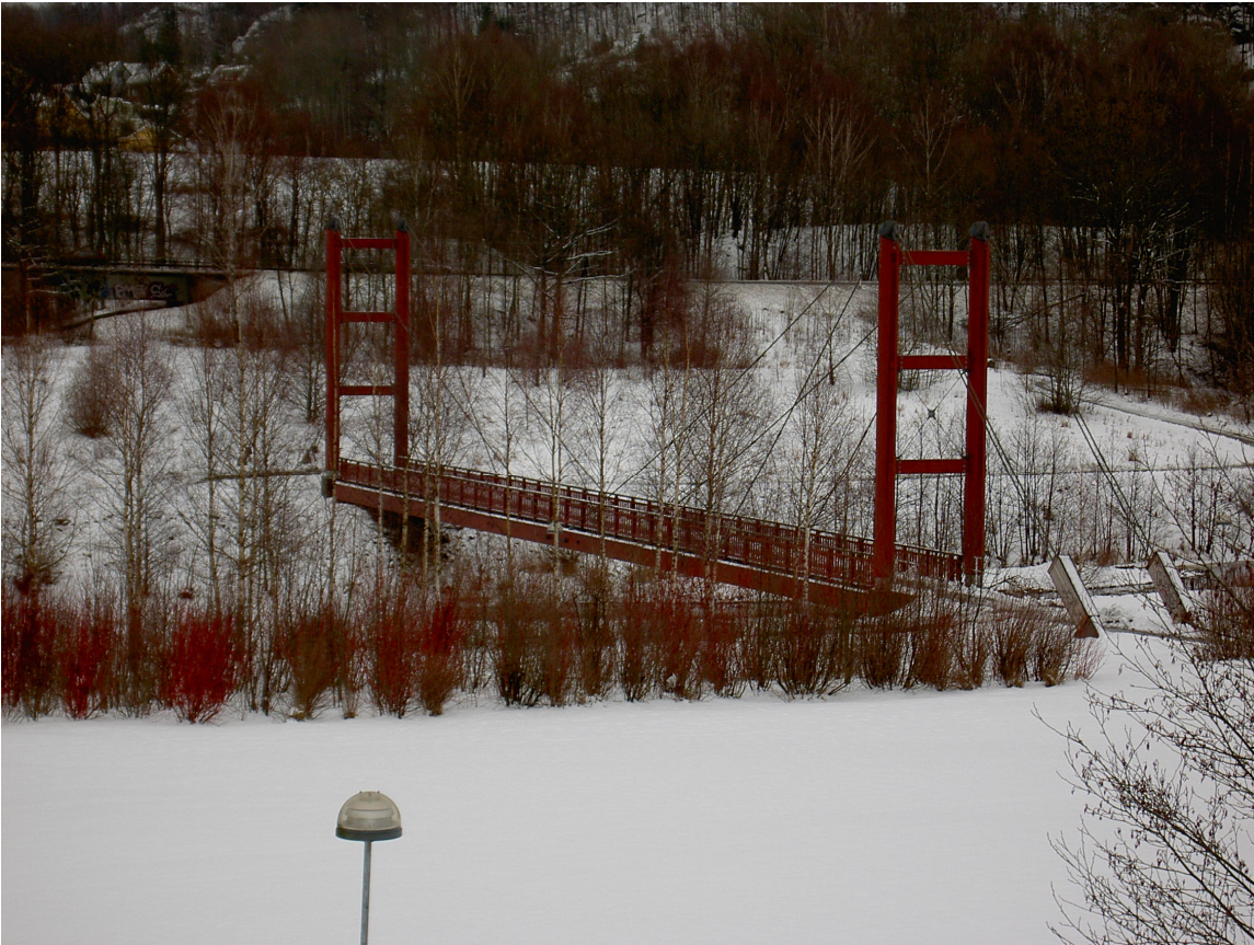
Bild 7: Snedkabelsbro över Örekilsälven i Munkedal (Fotograf: P Andersson)
