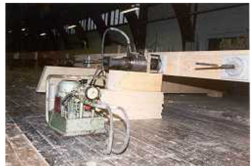
Bild 4: Hydraulisk domkraft för tvärspanning av ståltag
