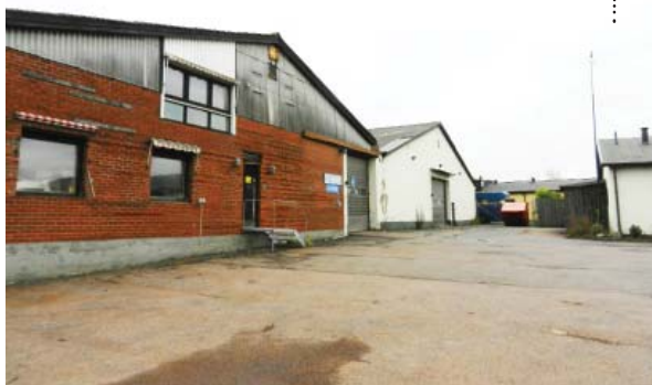
Byggnader utan hyresgäster är i dåligt skick och skulle kunna byggas om eller bytas ut
