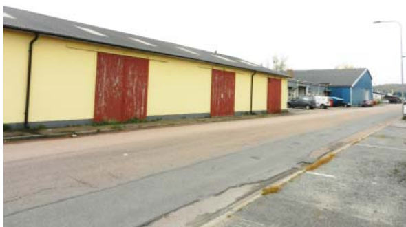
Stålverksgatan som leder till kvarteret har smala trottoarer och passiva fasader
