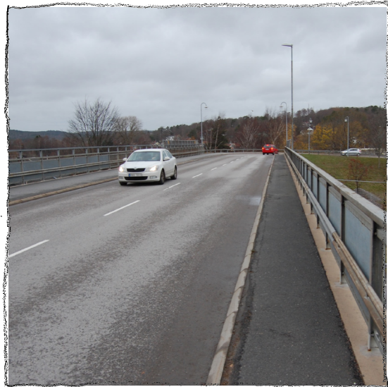
1. En cyklist närmar sig resecentrum söderifrån på viadukten över E20 och järnvägen. Cykelbanan har flyttats till höger sida av vägen.
