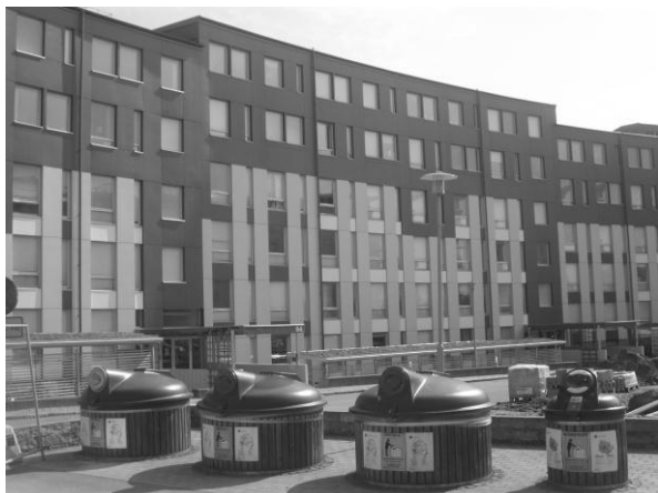
Figur 4 - Tillbyggnation vid Gibraltargatan 84-92
