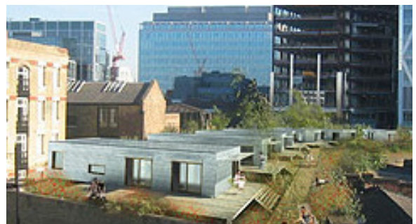
Figur 10.2 Montage av M-house på ett av Londons tak
