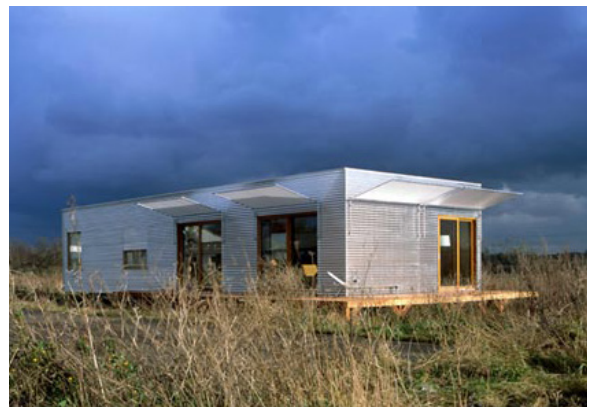
Figur 10.1 Exteriör vy av M-house
